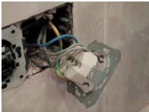
Enchufe con toma de tierra (cable amarillo y verde)
